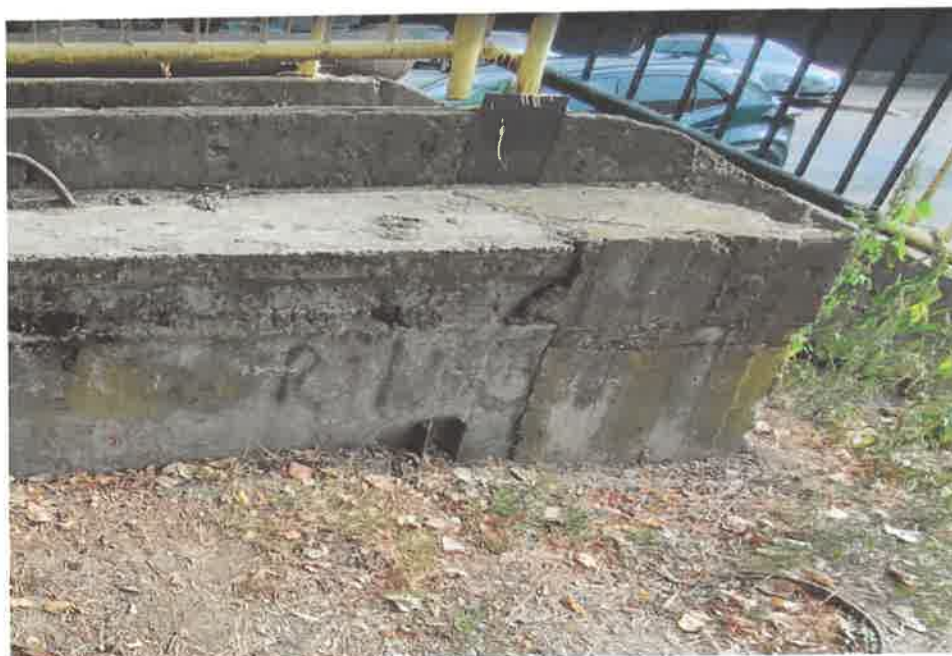
Foto 13, 14, 15: Vedere elemente de rezistență ce susțin calea – Placa de suprabetonare, antretoaze
