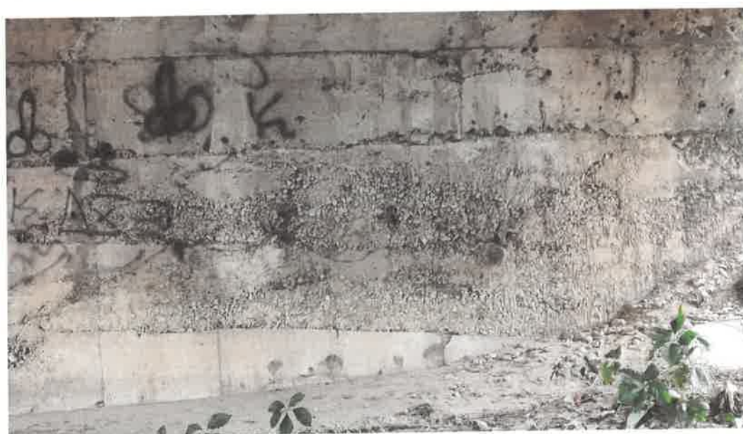
Foto 7,8,9: Degradari culee
