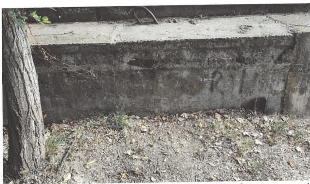
Foto 9, 10, 11, 12: Vedere suprastructura – Fasii cu goluri utilizate la sustinerea conductelor
