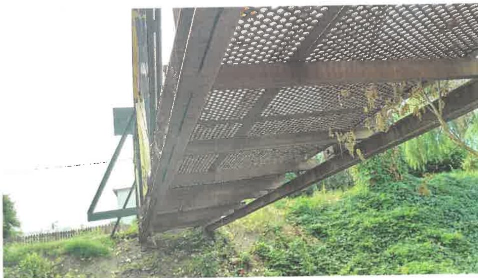
Foto 6, 7, 8, 9, 10: Vedere suprastructura degradata
