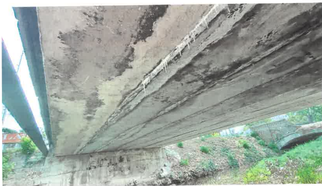
Foto 10: Vedere intrados suprastructura - Stalactite
