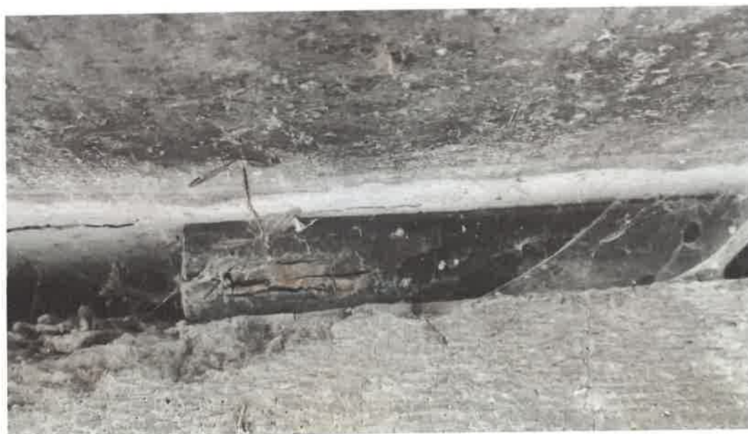
Foto 15: Degradari aparate de reazem
