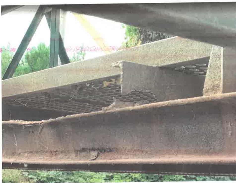
Foto 6, 7, 8, 9, 10: Vedere suprastructura degradata
